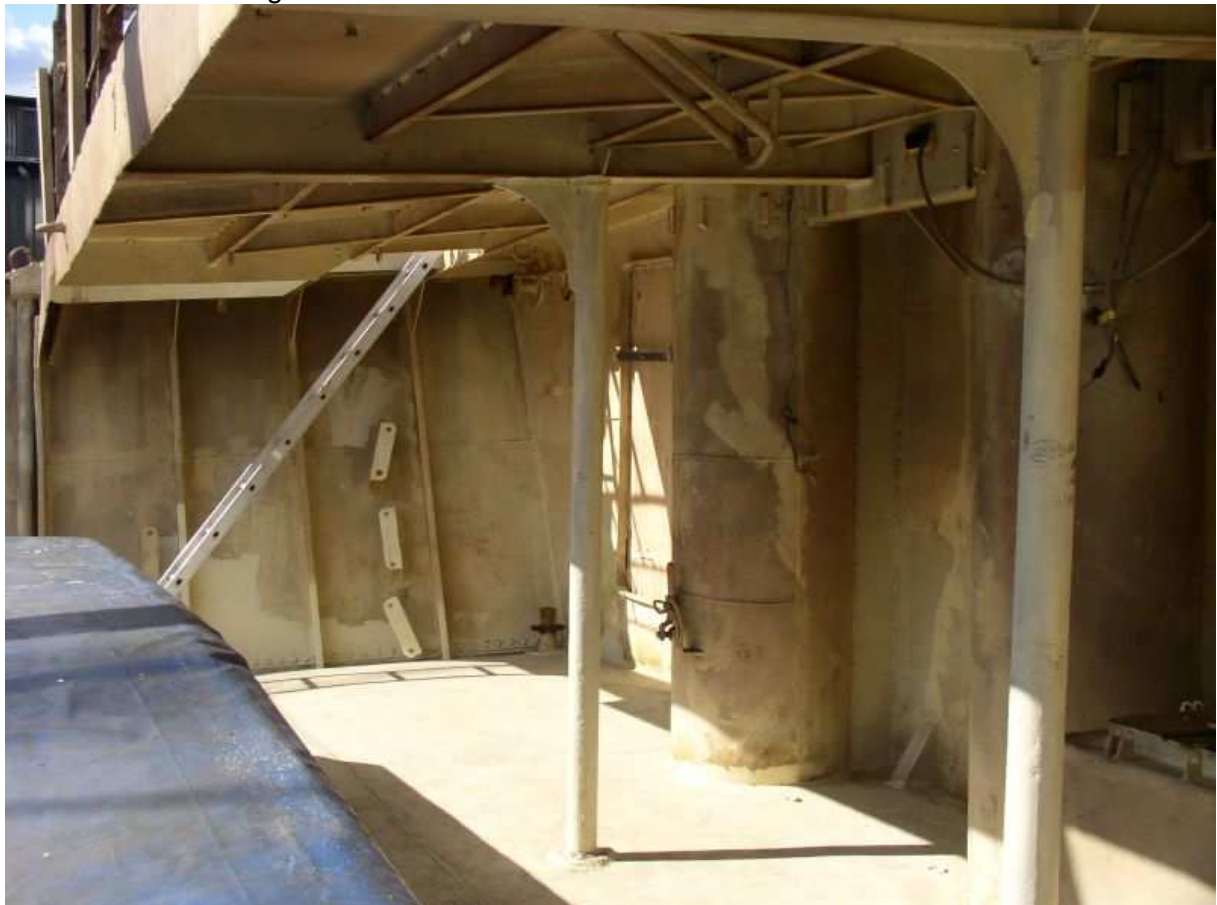
Nach Beendigung der Strahlarbeiten
