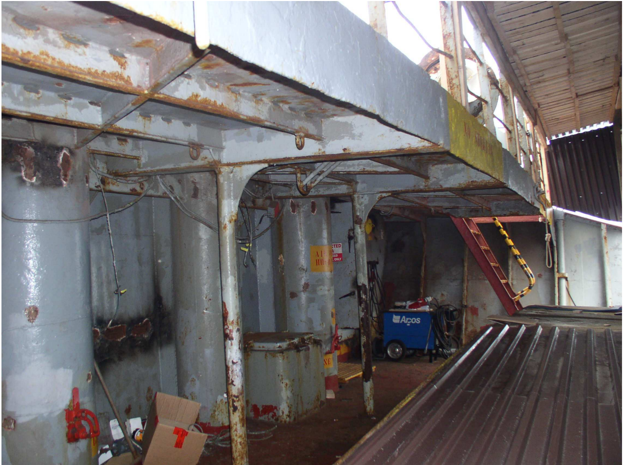
Vorschiff Vor Beginn der Strahlarbeiten
