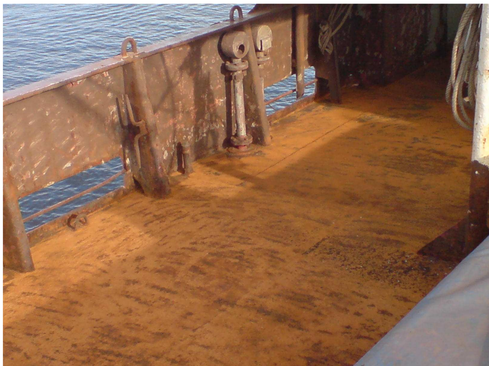
Deck nach dem Rostklopfen mit Wasser (Aqua blast)
