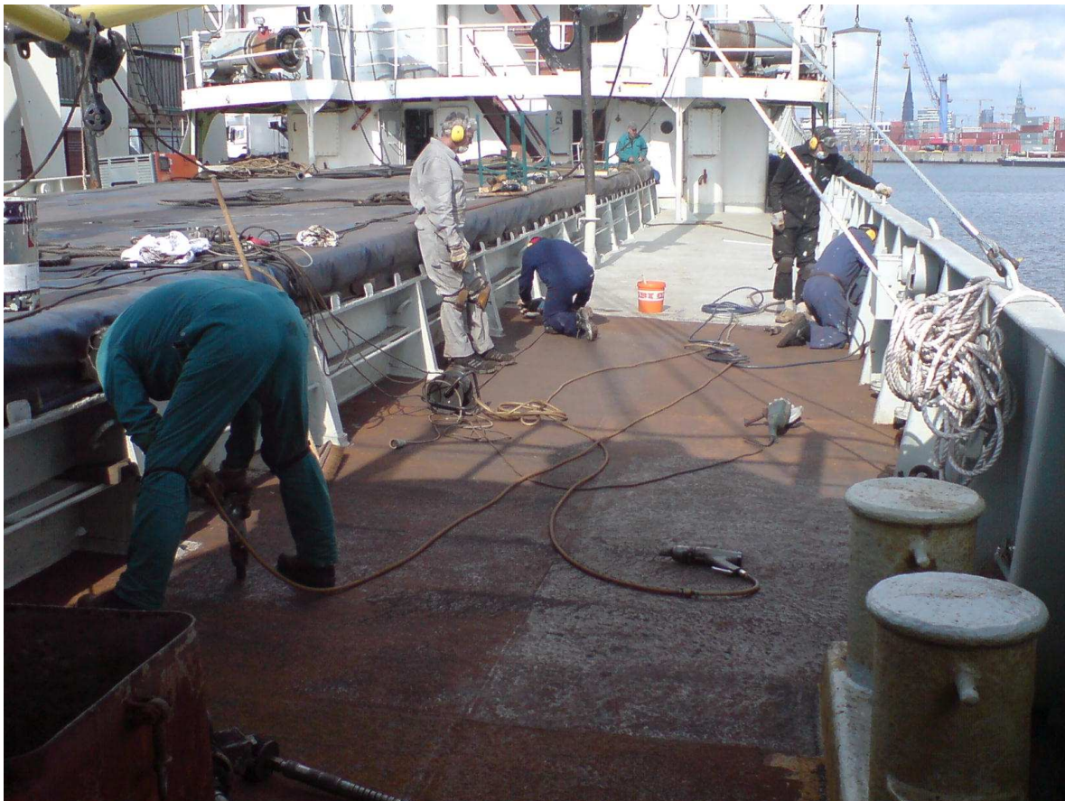
Nacharbeiten der Decksfläche
