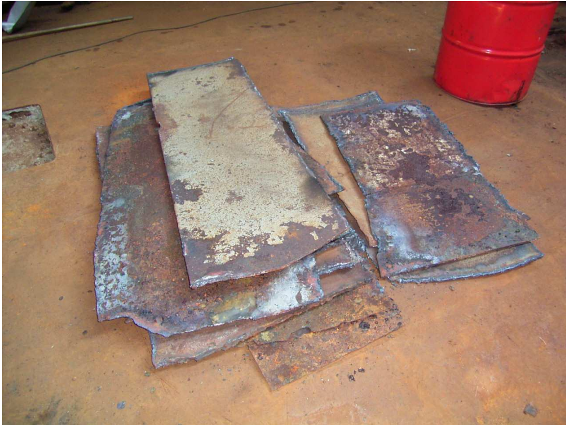
Die abgebrannten Stahlplatten werden gestapelt und später an Deck gewincht
