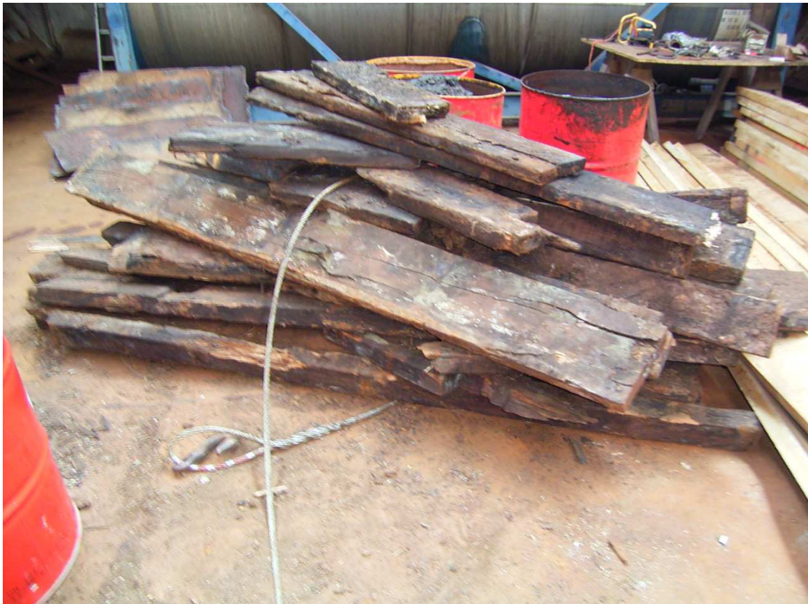
Das entfernte Material wird zum Abtransport vorbereitet.
