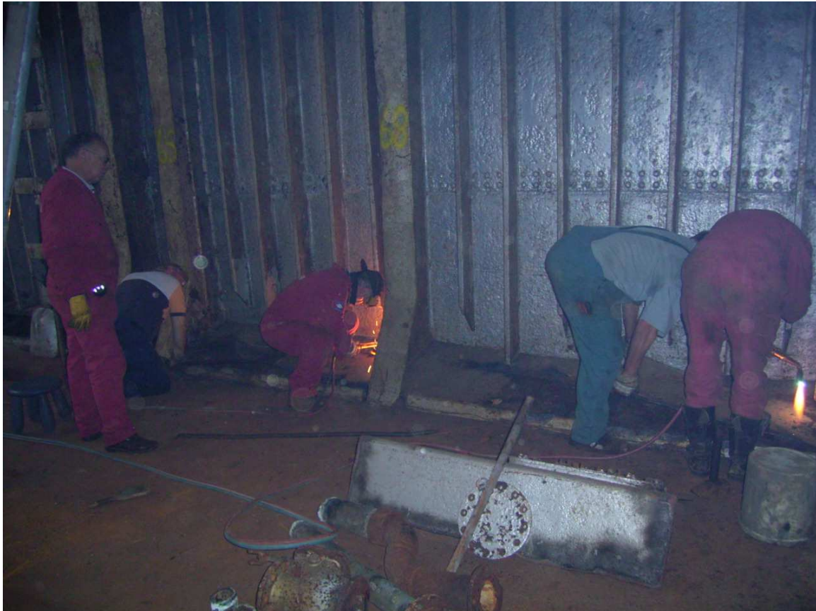
Fast geschafft, die letzten Spantenfelder
