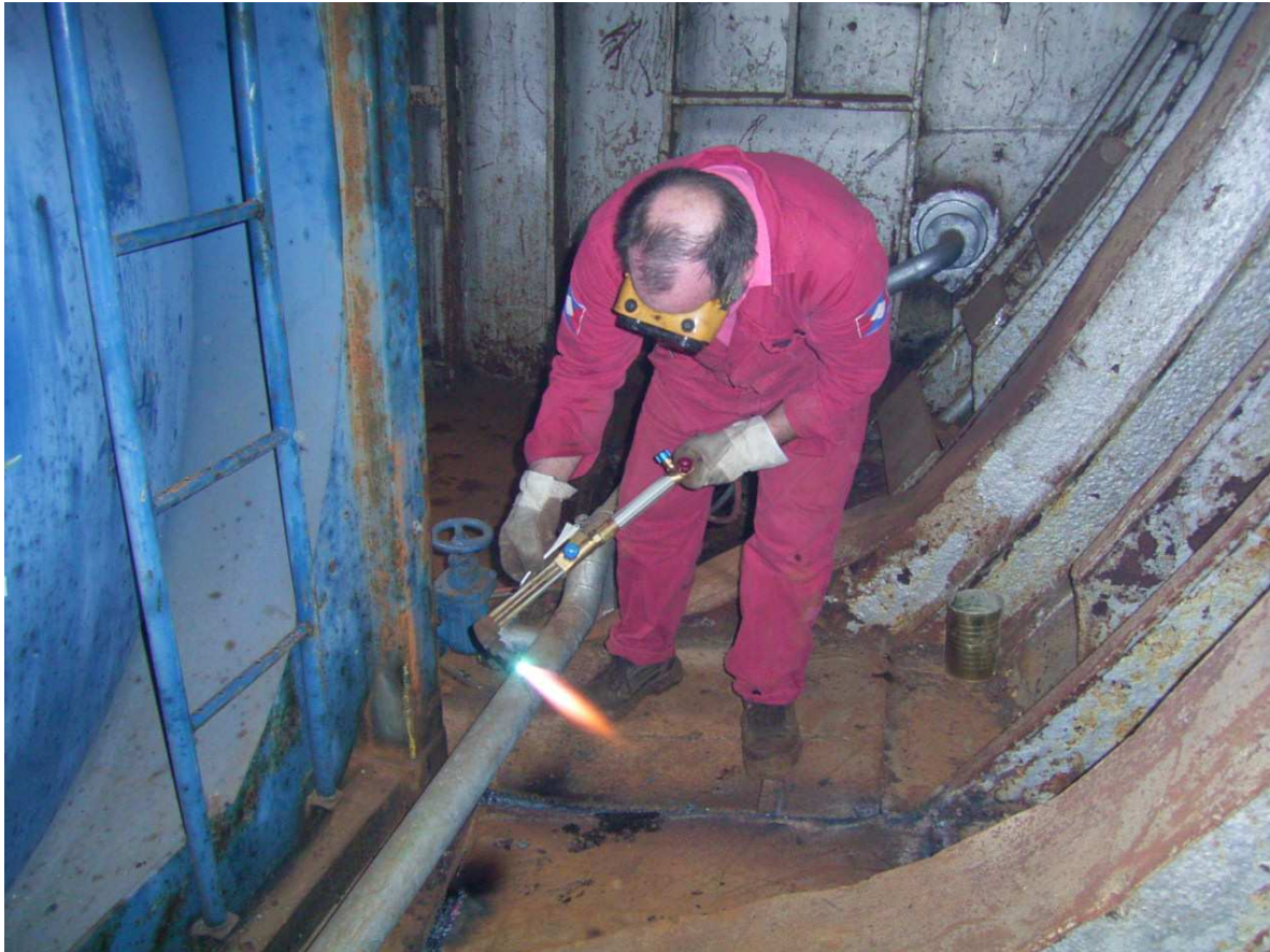
Die ersten Schweißnähte auf der Bb-Seite sind abgebrannt
